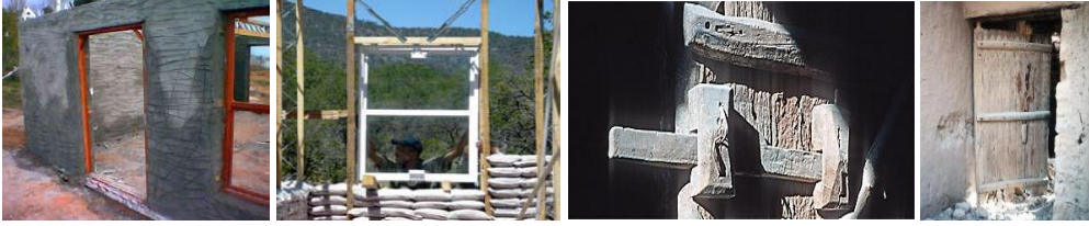
شكل ( 19 ) صور توضيحية للطريقة التنفيذية لفتحات الأبواب و النوافذ.
